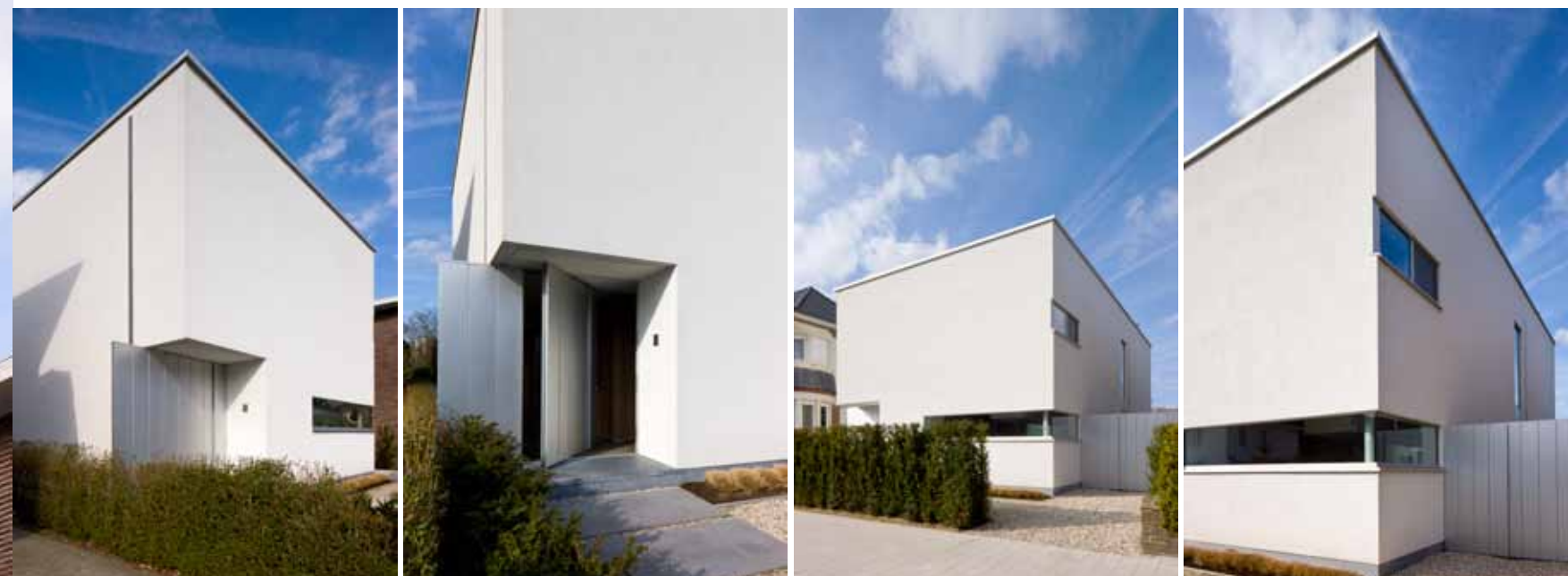
De witte siliconenpleister op de buitenmuren benadrukt de strakke vorm van de woning.
